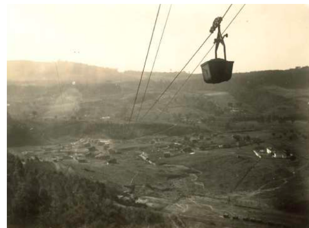
Cable aéreo utilizado en el transporte del carbón. Vista parcial de la comunidad de Rio Deserto, en Urussanga (SC), en la década de 1930.
